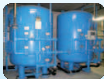
Filtrazione su letto a quarzite e carboni attivi
